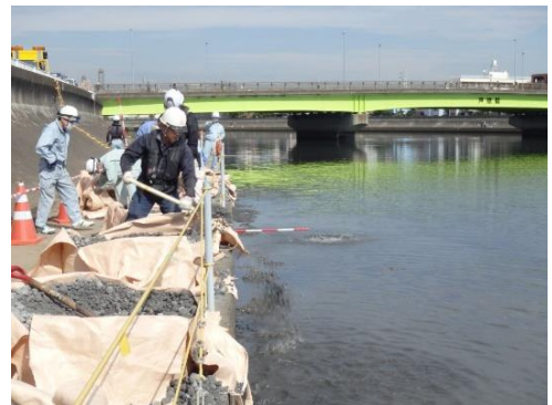
石炭灰造粒物敷設状況（小規模施工） （関東地方での活用事例：1級河川鶴見川）
