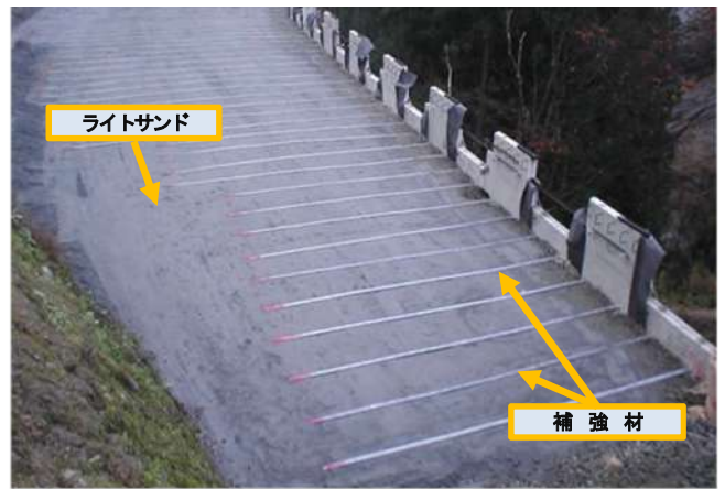
湯来バイパス道路新設工事(広島県)
