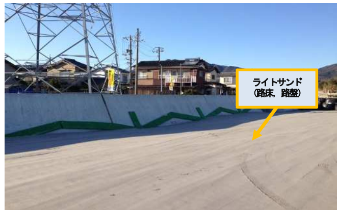
防府市内県道改良工事(山口県)
