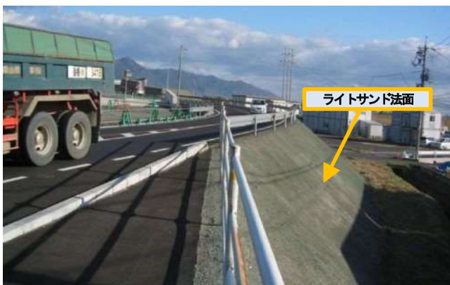
出雲バイパス改良工事(国土交通省)
