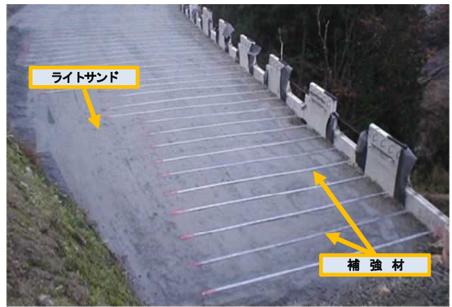
湯来バイパス道路新設工事(広島県)
