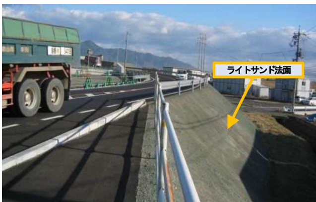
出雲バイパス改良工事(国土交通省)
