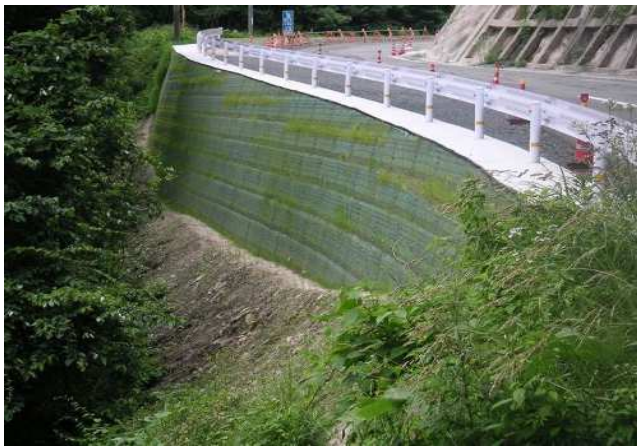
浜田市内県道改良工事(島根県)
