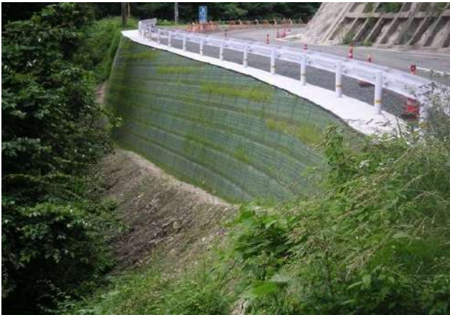
浜田市内県道改良工事(島根県)
