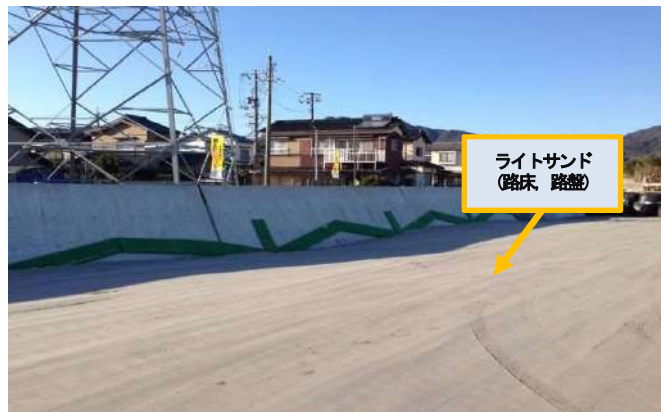
防府市内県道改良工事(山口県)
