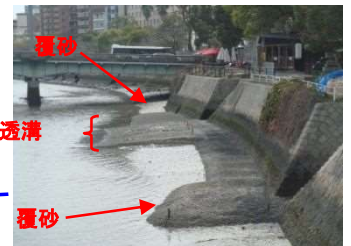
京橋川「水辺のオープンカフェ」前面河川干潟地点での実証試験
