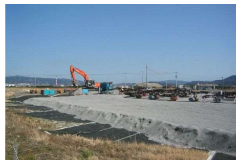
埋立地敷砂(重機作業床)
