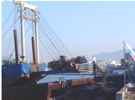
高潮対策堤防工事築堤材の下層に敷設(トラフィカビリティ確保)
