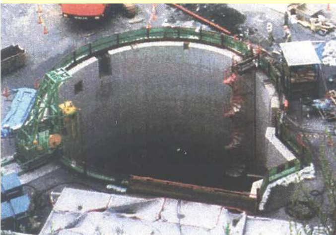
【大規模地下空洞(奥津第二発電所)】
