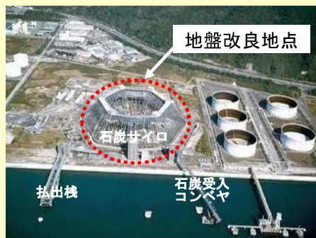
下松石炭中継基地(建設時)
