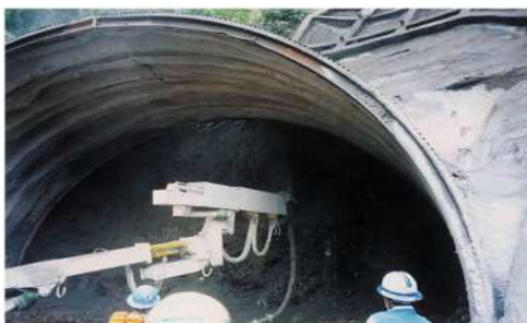
EPショット(トンネル吹付)
