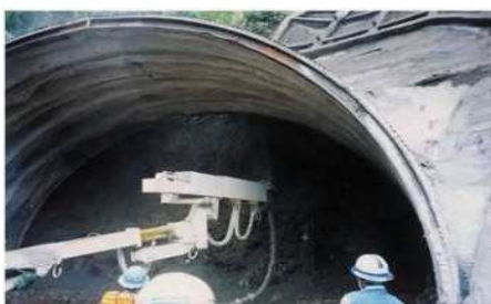
EPショット(トンネル吹付)
