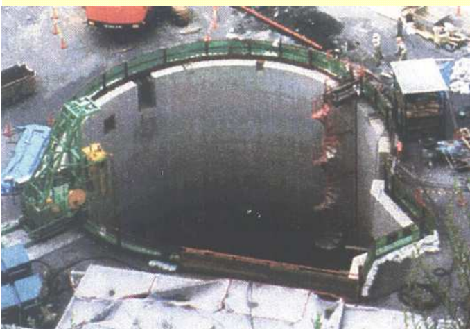
【大規模地下空洞(奥津第二発電所)】
