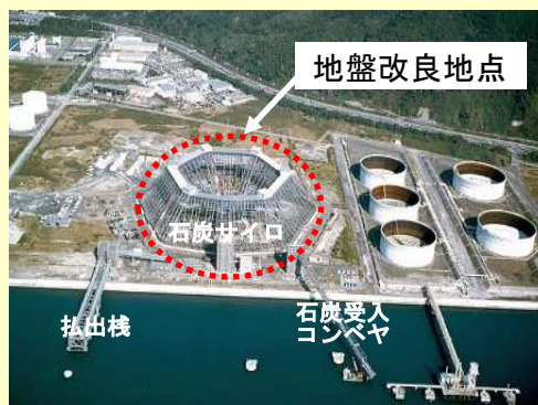
下松石炭中継基地(建設時)
